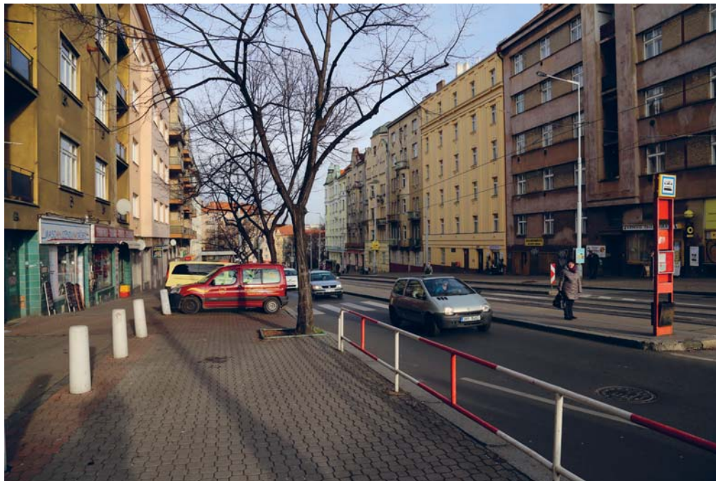
Současný stav pražské ulice Tábořská Foto: archiv IPR Praha
